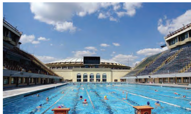
В результате реконструкции площадь зеркала воды в бассейне увеличится втрое.
