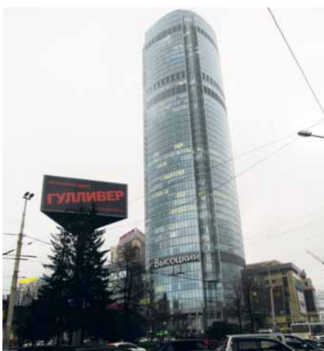
Гордость Екатеринбурга — 188-метровый БЦ «Высоцкий» с видовым рестораном на 51-м этаже.
